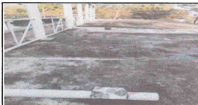
Foto 6: SUSTITUCION DE BAJADA DE AGUA PLUVIAL DE METAL POR TUBO PVC 3"
