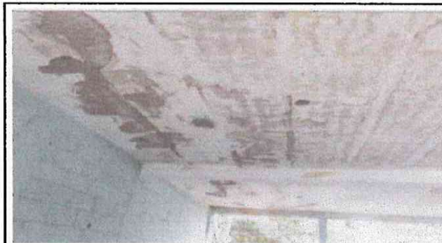
Foto 4: REPARACION DE LOSA
