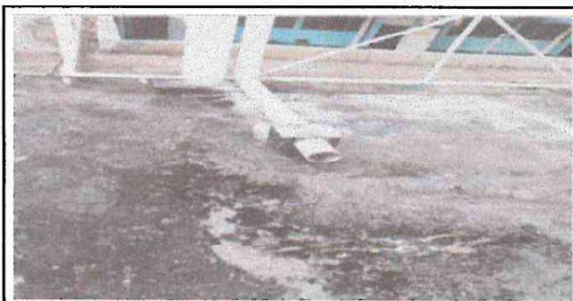
Foto 5: SUSTITUCION DE BAJADA DE AGUA PLUVIAL DE METAL POR TUBO PVC 3"
