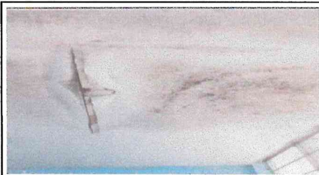
Foto 3: REPARACION DE LOSA
